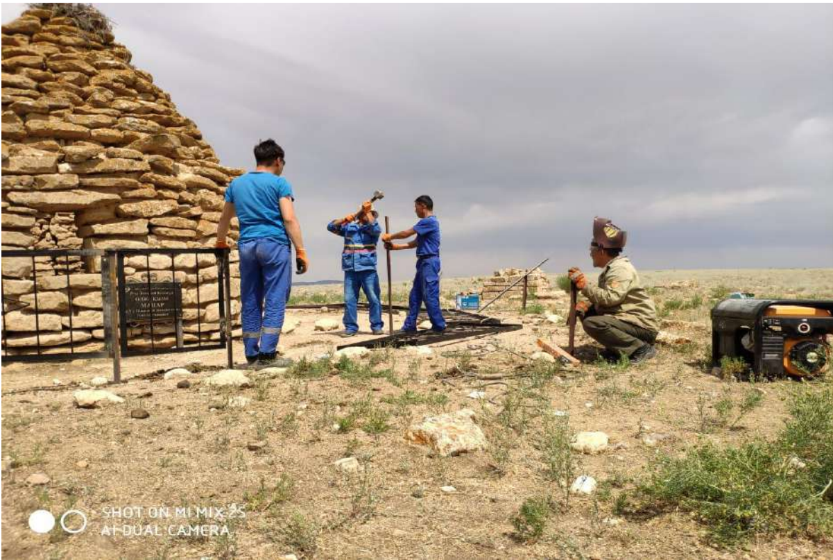
Ремонтные работы мавзолея
