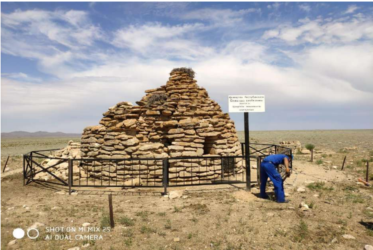
Завершение ремонтных работ
